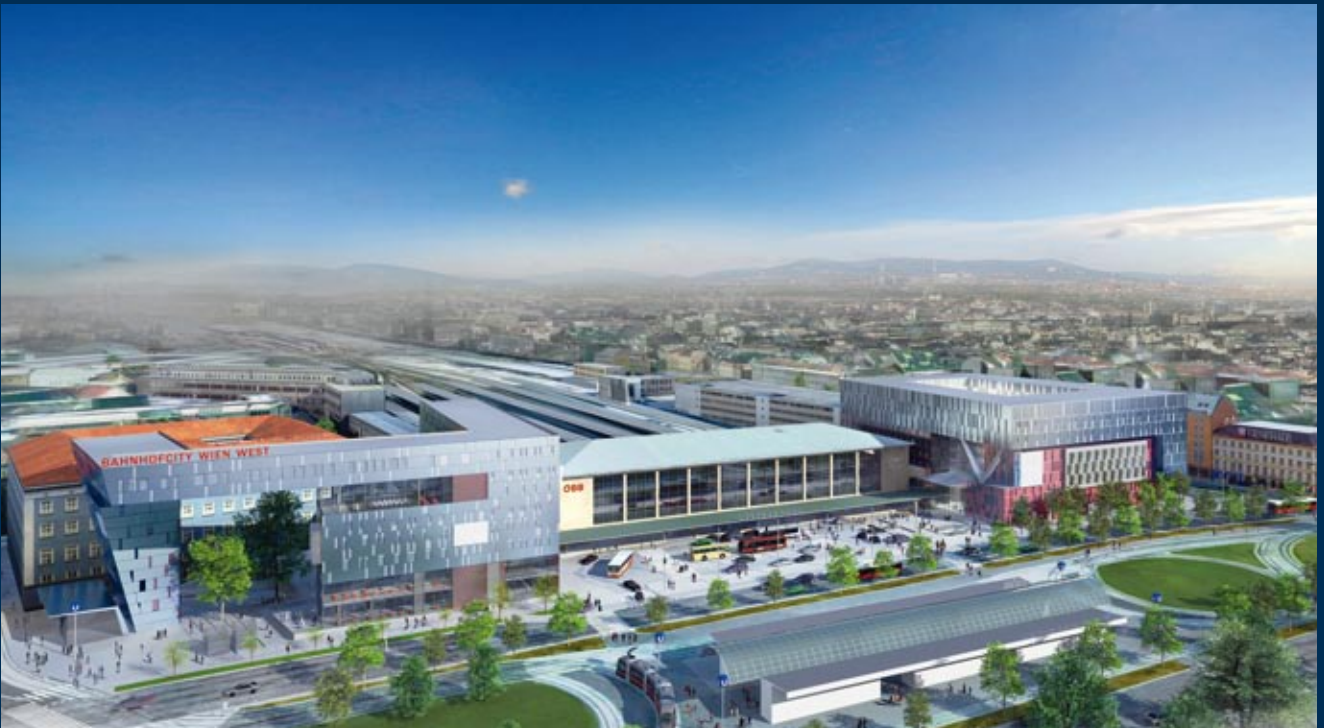
Seit Mitte September 2008 wird der Westbahnhof bei laufendem Betrieb einer Modernisierung unterzogen. Im Herbst 2011 ist die Eröffnung von Österreichs erster BahnhofCity geplant.
