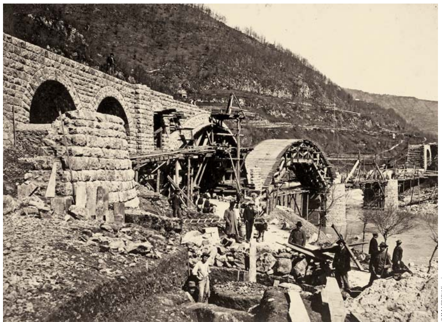
Bau eines Viadukts entlang der Bahnstrecke Villach–Triest (Wocheinerbahn).
