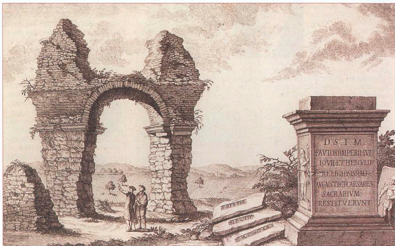
Heidentor nach Mansfeld (1780/90) – Ansicht von Osten.
