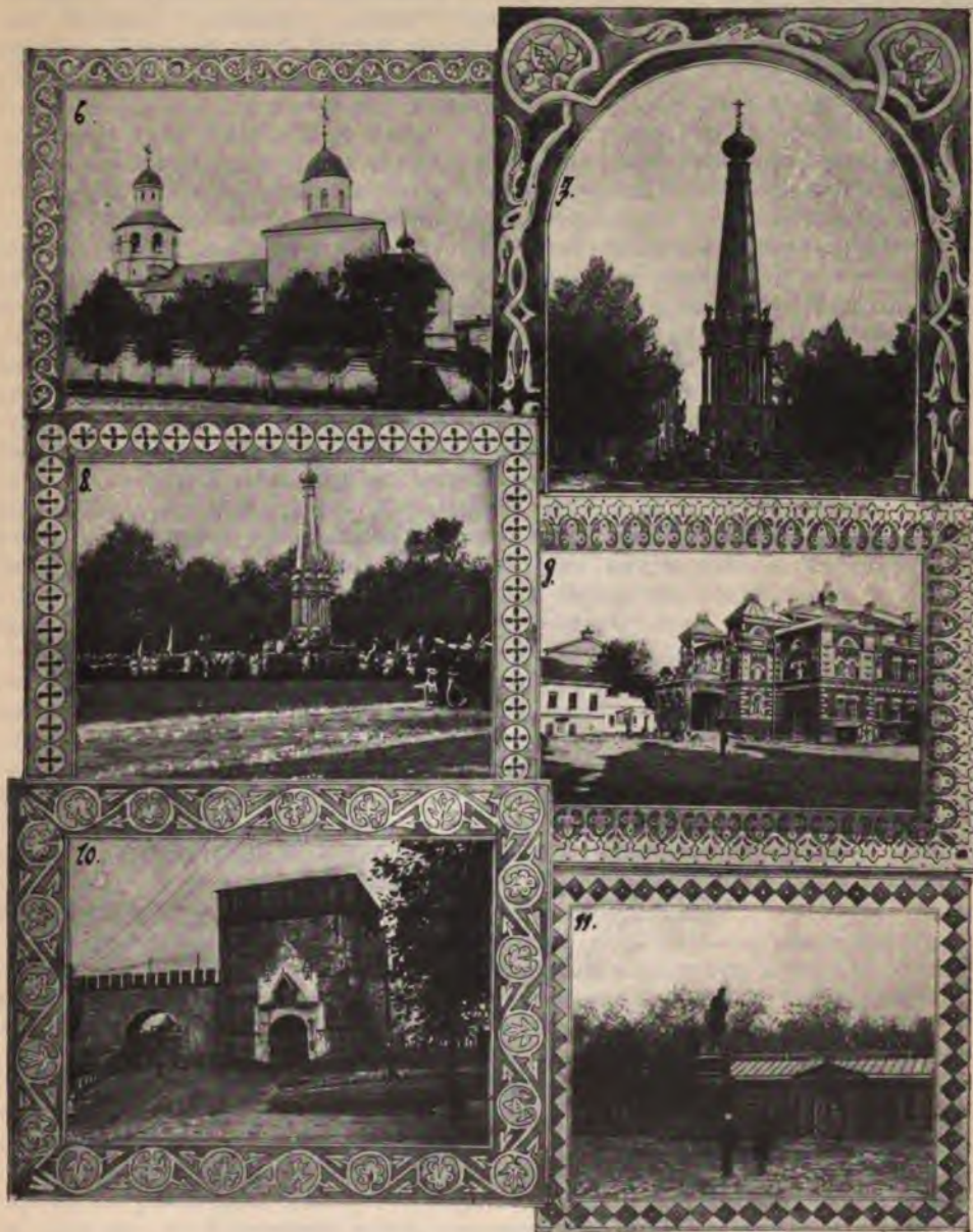
6. Вознесенскій женскій монастырь на Вознесенской горѣ.—7. Памятникъ 1812 г.—8. Шествіе вольнаго пожарнаго общества у памятника 1812 года во время празднованія 25-ти-лѣтняго юбилея Общества.—9. Городской театр.—10. Никольскія ворота.—11. Памятникъ композитору Глинкѣ.
