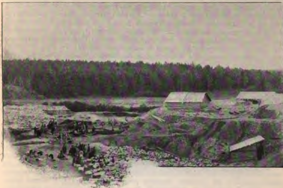
Кессонныя работы въ 5 вер. отъ Орши на строящейся Витебско-Жлобинской жел. дор.
