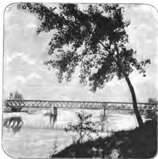
Мостъ черезъ Ворсклу на Харьковско-Николаевской ж. д. (По фот. Б. П. Алмазова).
