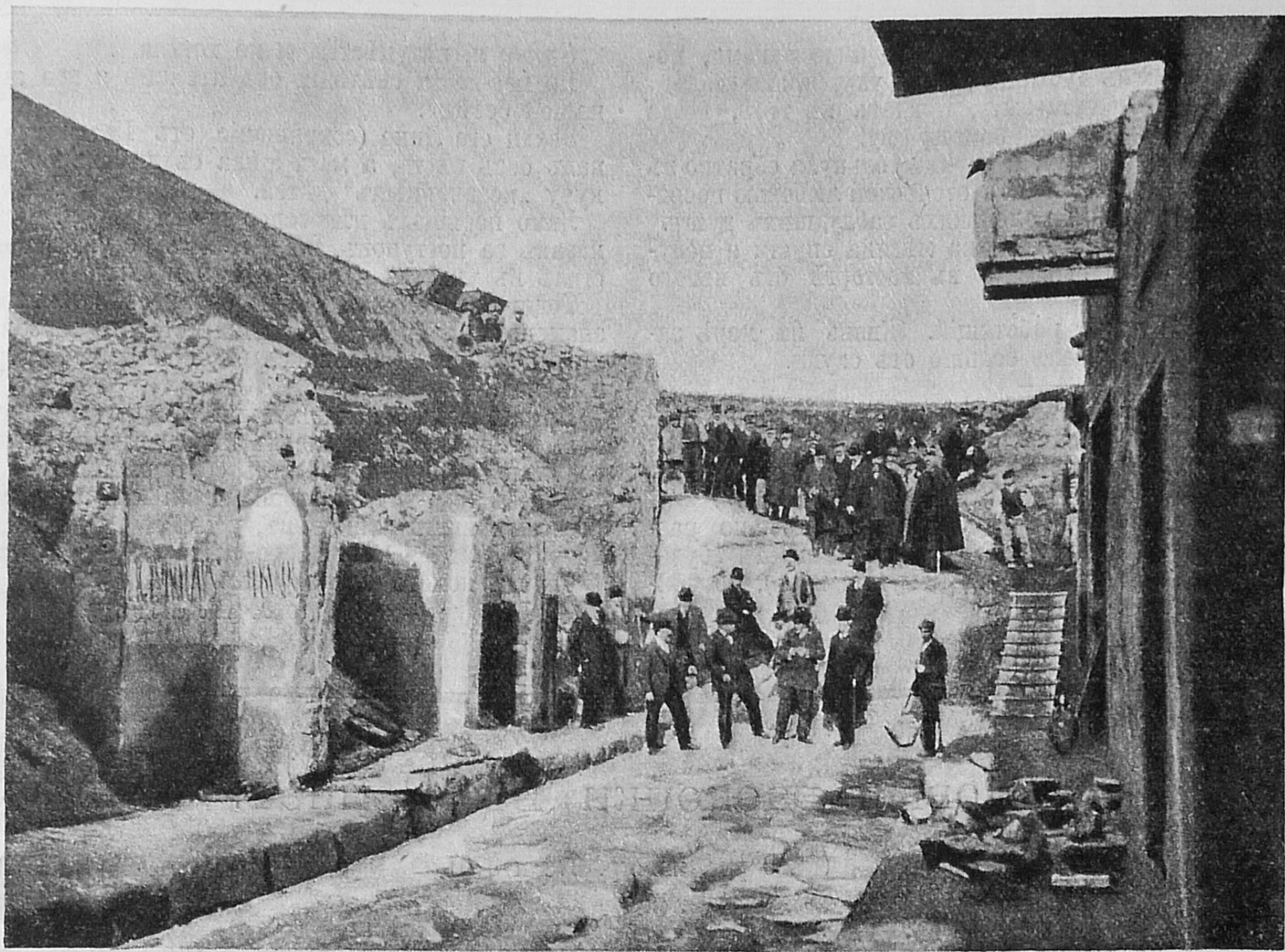
„Улица Изобилія“, только-что откопанная; направо — дома, у которыхъ удалось отчасти сохранить балконы.
