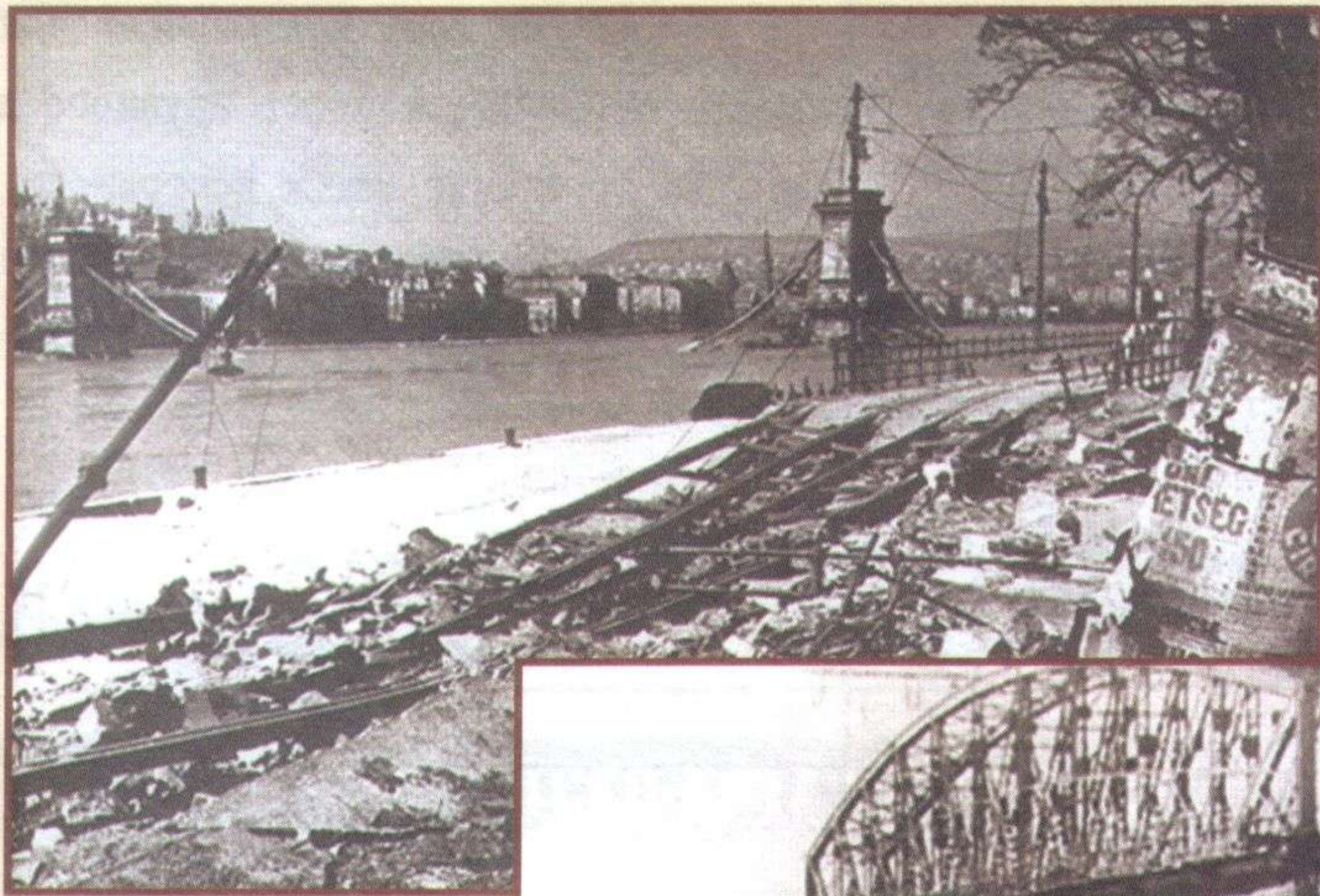
Будапешт. Бои окончены. Всё, что осталось от моста
