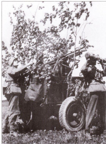
Мобильный зенитный станок для спаренных пулеметов MG 34 — Zwillingswagen. Такие колесные станки часто буксировались лошадьми.
