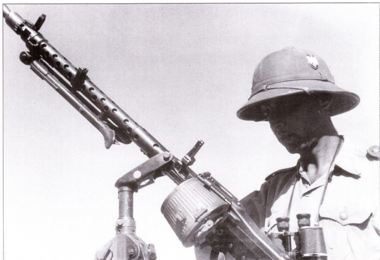
Пулемет MG 34 на облегченной треноге Dreifuss 34. Пулемет снаряжен 50-зарядным барабанным магазином.
