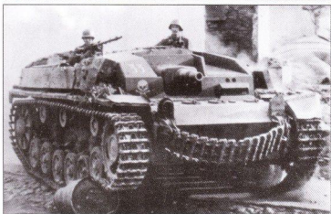
Штурмовое орудие Sturmgeschütz III ранней серии, восточный фронт. Эти машины стандартно комплектовались пулеметом MG 34, установленным на крыше у люка заряжающего.
