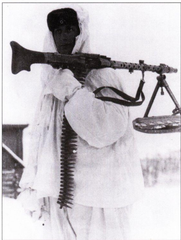
Сошки пулемета дополнены снегоустойкой, чтобы они не проваливались в рыхлый снег, восточный фронт, 1942 г.
