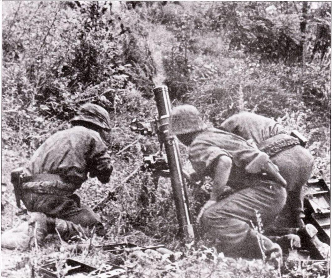
Расчет 80-мм миномета GrW34 ведет огонь по противнику. Миномет окрашен в серый цвет, но внутренние поверхности прицела - белые. Коробки для мин окрашены в серый цвет. Большинство минометчиков вооружено пистолетами.
