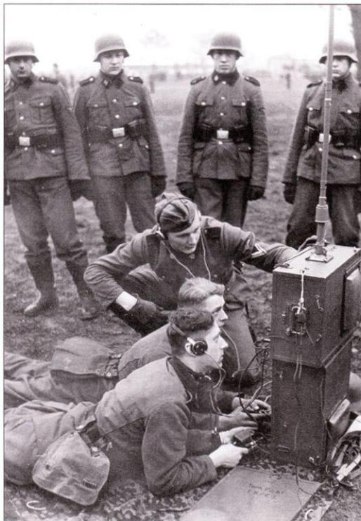
Радисты на тренировке, радиостанция - Tornisterfunkgerät b1 (Torn.Fu.b1 (S/E), компактная радиация). Снимок марта 1941 г. Такие радио широко применялись в войсках СС. Рация состояла из двух частей, верхней и нижней, каждую из которых мог переносить один солдат.
