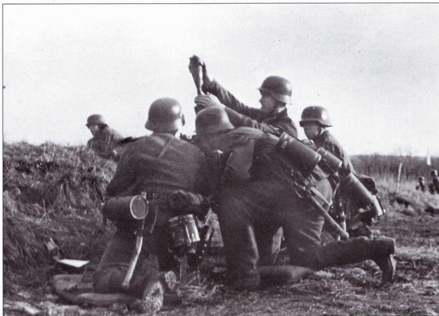
Расчет 80-мм миномета на огневой позиции. В ствол миномета опускается дымовая мина. Дымовые мины от фугасных отличались только маркировкой «Nb» - Nebel. Фугасные и дымовые мины к германскому 80-м миномету весили одинаково, обладали одинаковой баллистикой. Максимальная дальность стрельбы 80-мм миномета составляла 1600 м, минимальная – 60 м.
