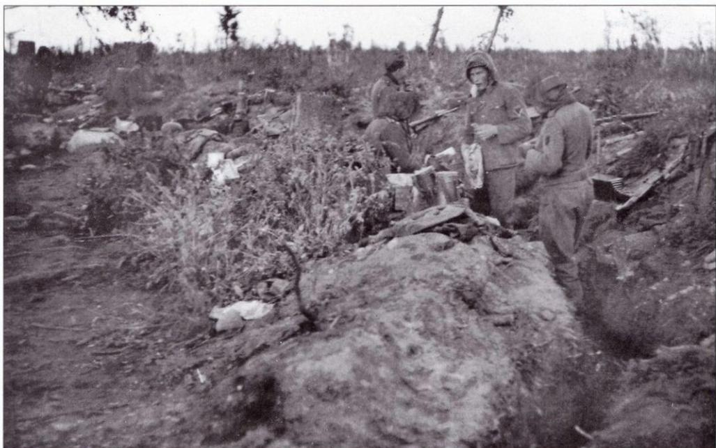
*Рубеж обороны взвода германской пехоты. В кадр попали стрелковые ячейки двух пехотинцев и место установки пулемета MG-34. Обычно в грунте сначала отрывались индивидуальные огневые позиции, которые потом соединялись траншеями в единый рубеж обороны. Траншеи обязательно делали извилистыми, чтобы она не простреливалась насквозь, от одного конца до другого. Бойцы укрывали головы от комаров тряпками.*
