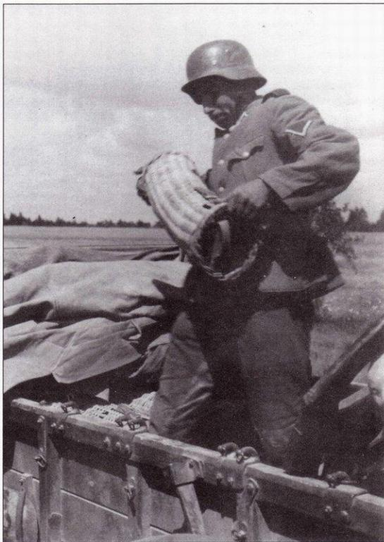
Артиллерист в звании ефрейтора вытаскивает из повозки «Koffer» - чемодан - заряд для 150-мм гаубицы в плетеном контейнере. Заряд весил 43,4 кг. Пустые контейнеры часто засыпали землей и использовали для обустройства траншей, огневых позиций и т.д.
