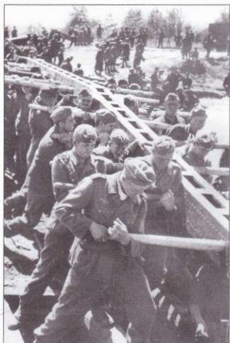
Саперы собирают из готовых стальных секций мост Bruckengerat-K. В зависимости от типа используемых секций, длина пролета моста «К» могла достигать 19 м. Более длинные мосты собирались в варианте с промежуточными опорами. Однопролетный мост выдерживал нагрузку в 27 т. Чаще всего мосты «К» наводились над оврагами и рвами, в случае организации мостовой переправы через водные преграды секи моста «К» использовались как часть понтонного моста.
