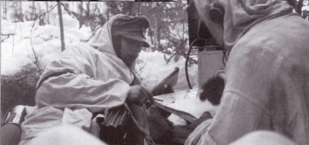
Портативная радиостанция Tornister Funkgerät k (T.Fug.k), развернутая на передовом командном пункте. Вести передачи с движущихся посредством данных радиостанций не представлялось возможным. Перед работой требовалось соединить электропроводкой блоки радиостанции и развернуть антенну. Тяжелыми были не только радиостанции, но и аккумуляторные батареи для них. Емкость батарей была совершенно недостаточной. В германской армии радиостов обычно называли «функер».
