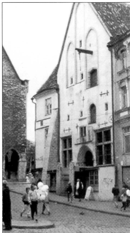
Купеческий дом XV в., Таллин, Эстония. В доме имелся склад, в стену встроена стрела для подъема грузов.
