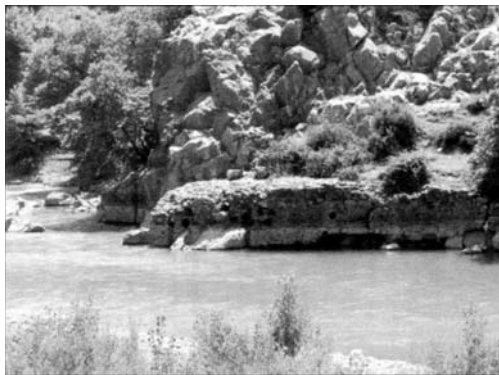
Остатки древнего моста, именуемые сейчас Ура-э-Хаккси Бэкарит (Ura e Naxhi Beqarit) через реку Генуус, откуда шло южное ответвление дороги вдоль реки Эгнатия к Аполлонии и Аспарагуму. В ходе отступления Цезаря от Диррахии он здесь пересек реку, и его арьергард постоянно отбивался от конницы Помпея, долго преследовавшей отступающих.
