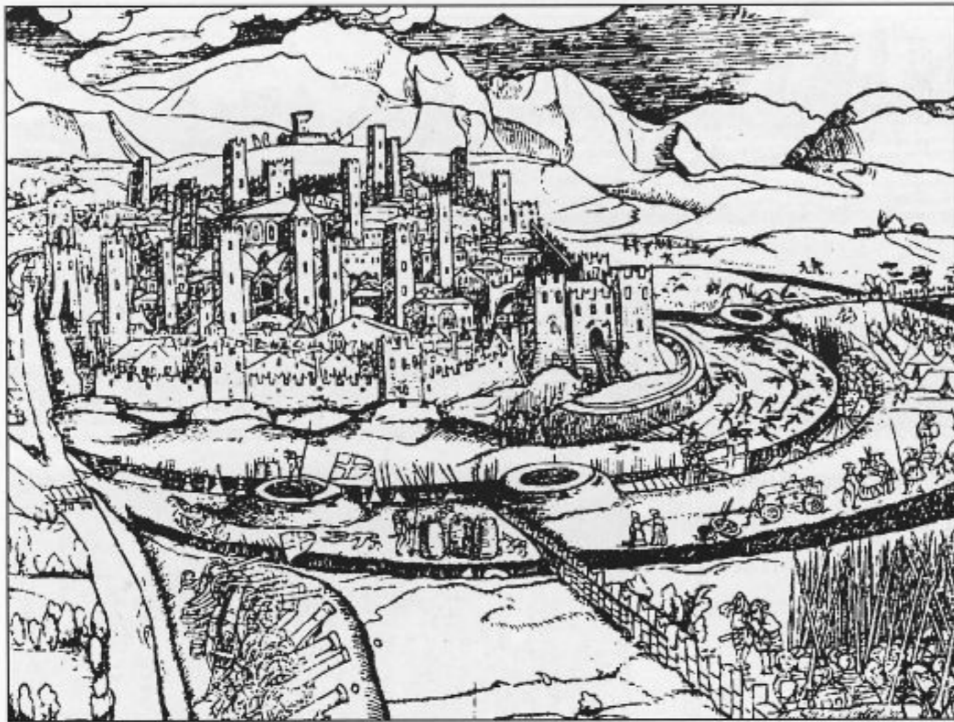
Йорг Брой, «Сражение при Павии, 1525», фрагмент гравюры на дереве, 1526 г. Хотя изображение достаточно схематично, оно дает ясное представление о земляных полевых укреплениях, возведенных вокруг Каstellо Висконти и у основания каждой башни городской стены. Отметьте круглые блокаузы, используемые и осаждающей, и осаждаемой стороной.
