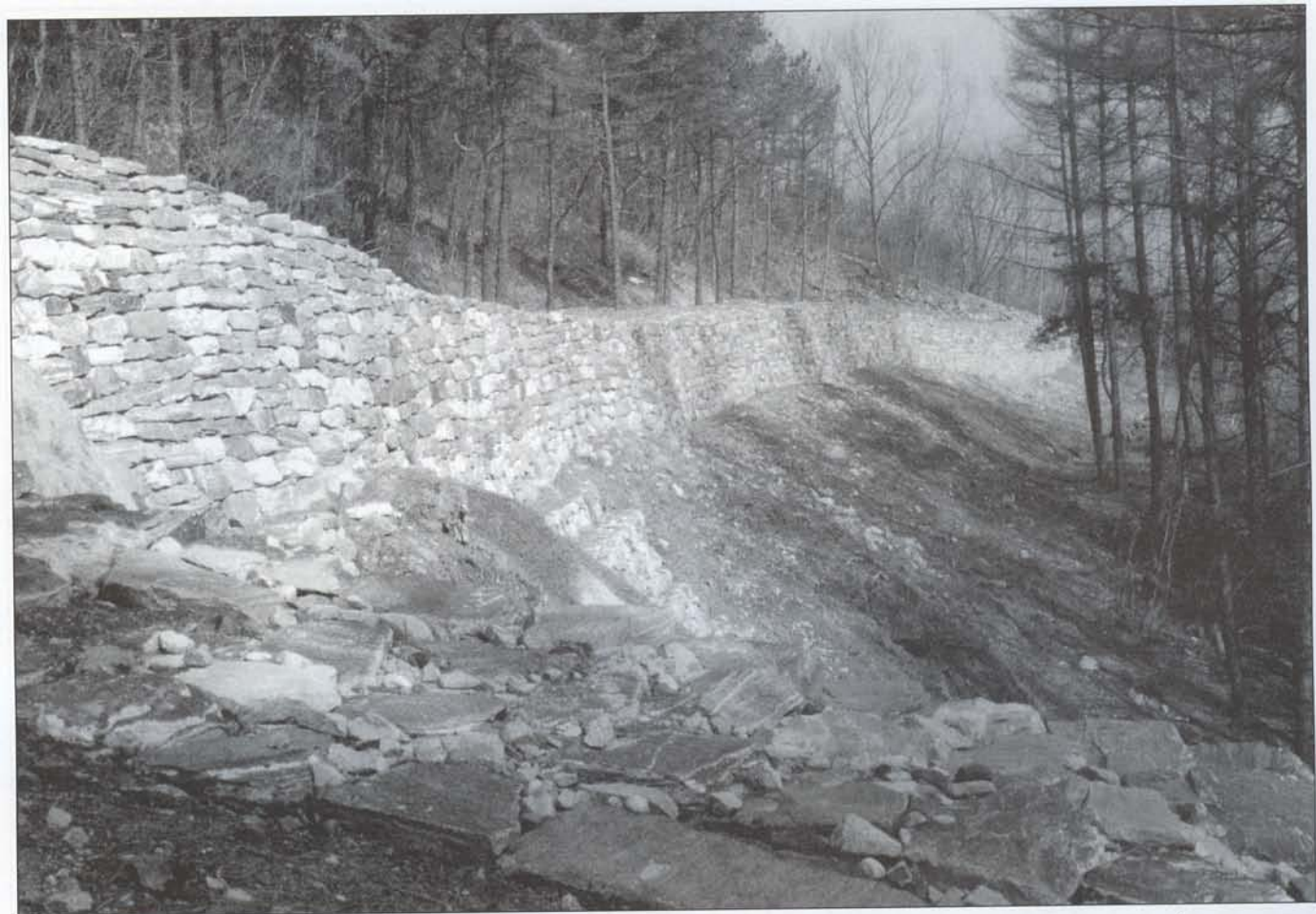
Простая стена корейской горной крепости (сансон) под Чхукджу. В 1235 г. здесь шла ожесточенная осада монголами корейских укреплений. Стены сложены из маленьких камней на горном склоне. Никаких попыток выровнять строительную площадку не предпринималось.
