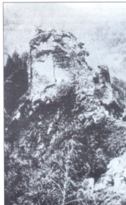
Разрушенная верхняя башня укрепления Курт де Аржес на южных склонах Карпатских гор.
