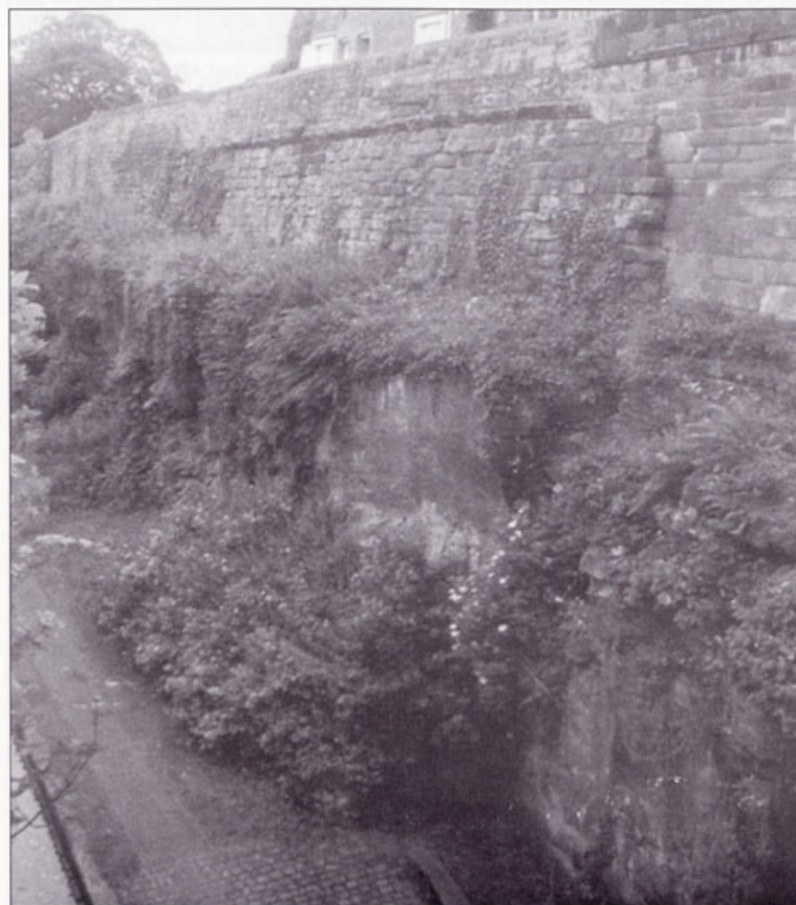
Крепость Дева (Честер, Англия). Уцелела северная стена. Метод укладки известен под названием opus quadratum. Большие каменные блоки длиной до 1,8 м укладывались друг на друга на скрепляющий слой извести. Работы закончены около 100 г.
