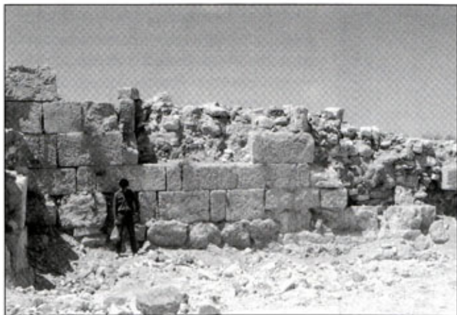
В Удрухе (Иордания) массивные стены толщиной 3 м имеют внутреннюю засыпку из булыжника и отделаны снаружи блоками из песчаника. На некоторых участках высота стены до сих пор достигает 6 м.
