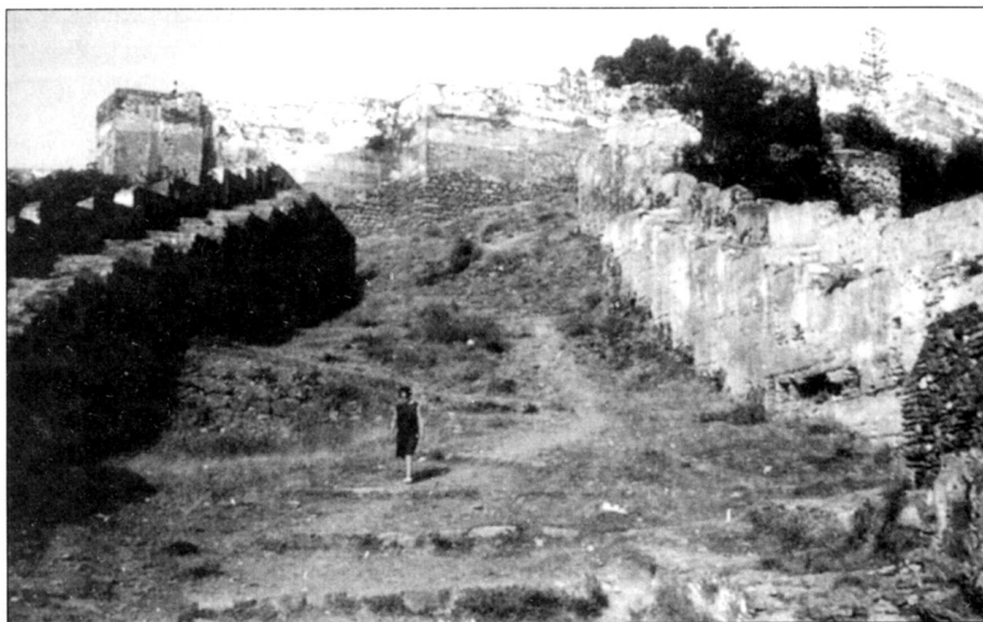
Характерная андалузская военная архитектура. Двойная стена, соединяющая город с передовым укреплением. Здесь за черту города был вынесен Гибралфаро или «маячный холм», замок, стоящий на крутом холме и господствующий над городом. Стены, соединяющие Малагу с Гибралфаро построены в XIV в.
