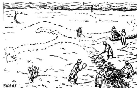
Рекомендованный метод маскировки германских траншей и ходов сообщения настилами и снегом. Рисунок из «Taschenbuch für den Winterkrieg» (ноябрь 1942 г.).
