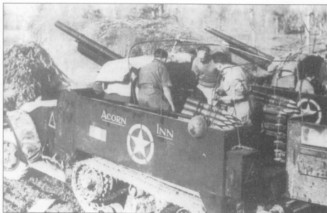
75-мм пушки, установленные на полугусеничный бронетранспортер М3. Такие самоходные пушки использовались в качестве первых американских истребителей танков. На снимке показаны бронетранспортеры, состоявшие на вооружении английской пехоты, сражавшейся в Италии. Здесь их используют в качестве самоходной артиллерии. Эффективность данных машин в роли истребителей танков была минимальна.
