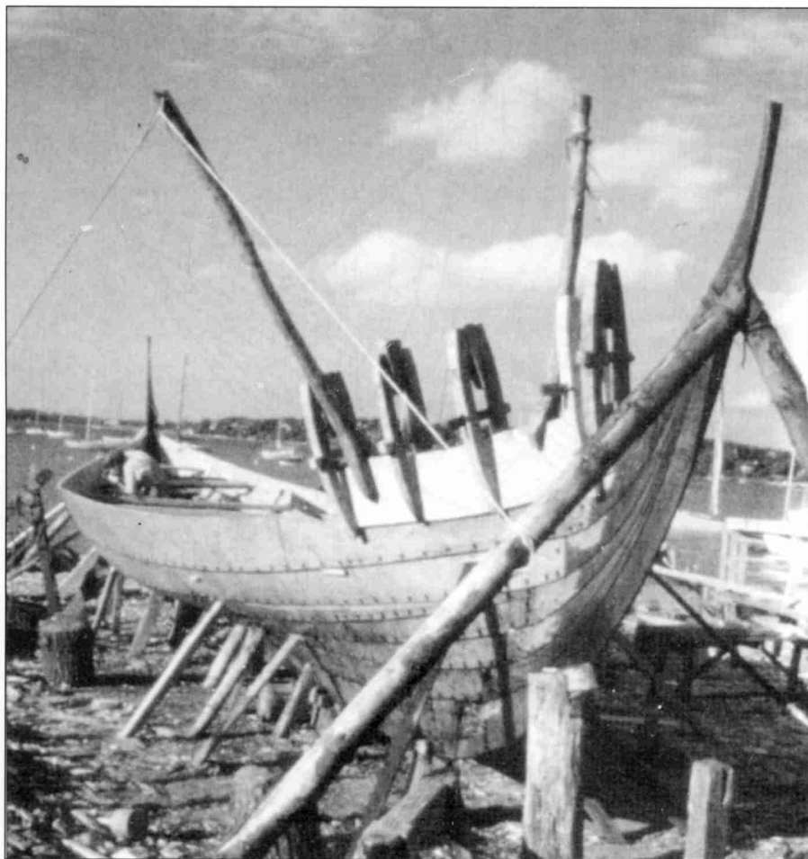
Реплика Скулделева-3 «Рор Эддэ» во время сборки в Роскильде. Обратите внимание на струбцины, которыми фиксируется на месте доска обшивки. Строительство шло по норвежским правилам, разработанным тысячу лет назад.
