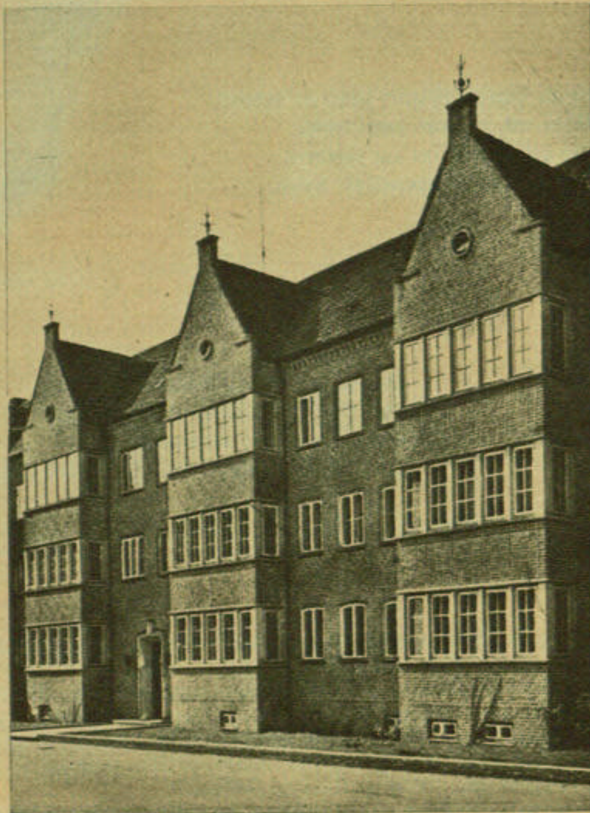
Wilhelm Rambacher, Gustav Hense: Aus der schönen Tradition des mittelalterlichen Baustils einer norddeutschen Stadt entstanden diese allen Ansprüchen unserer Zeit genügenden neuen Wohnhäuser
