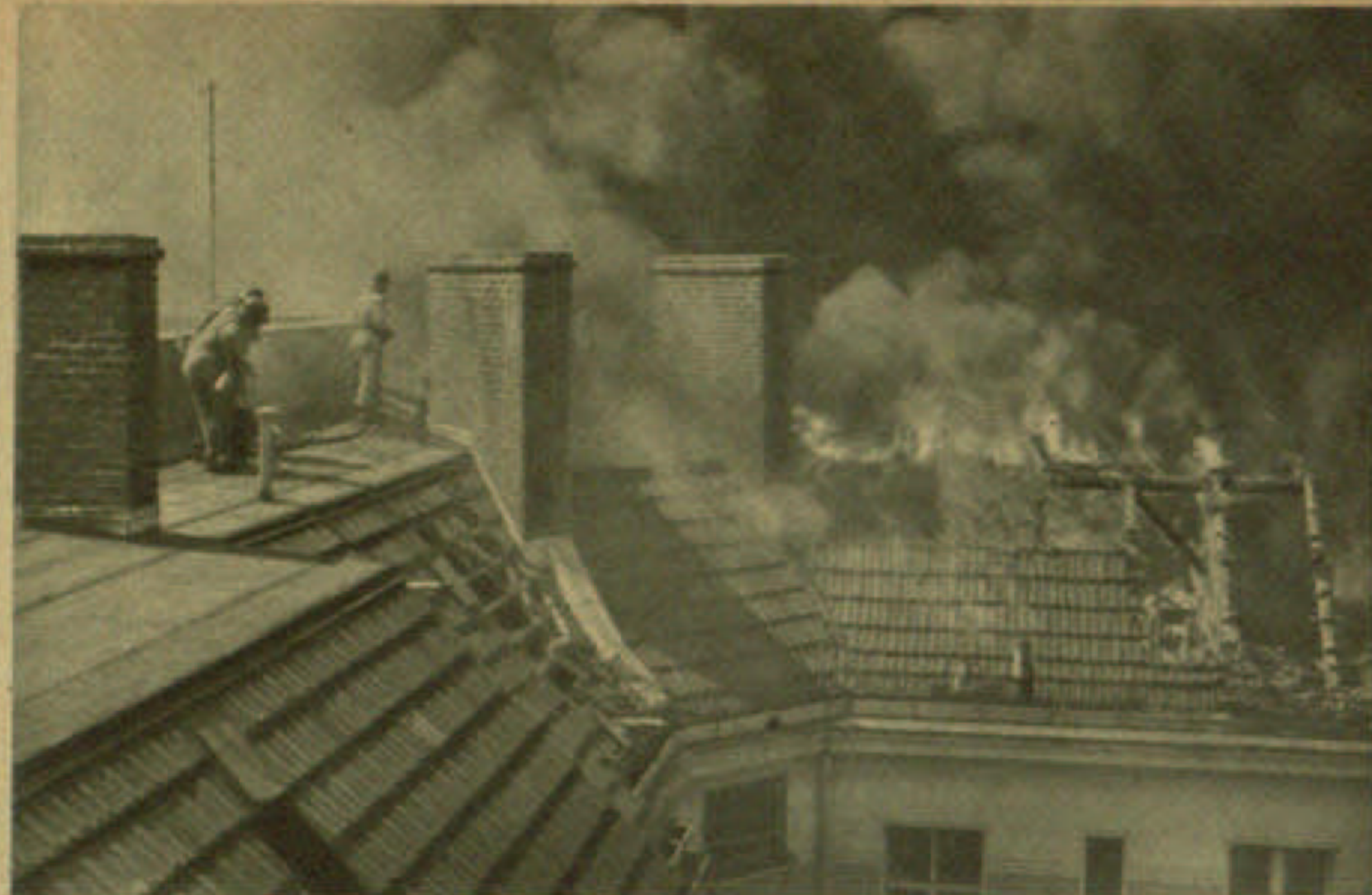
Der Brand wurde von Frauen so rechtzeitig gelöscht, daß er auf die anderen Dächer nicht übergreifen konnte. Aufnahme: Reichsanstalt für Luftschutz
