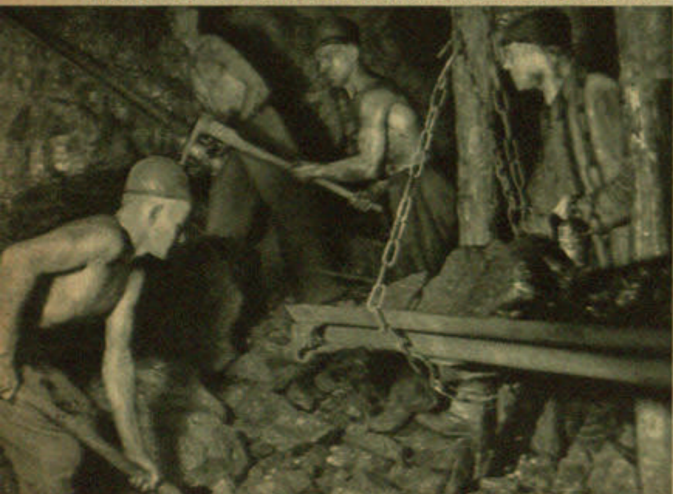
Tief unter Tage verrichtet der oberschlesische Bergmann seine harte Pflicht
