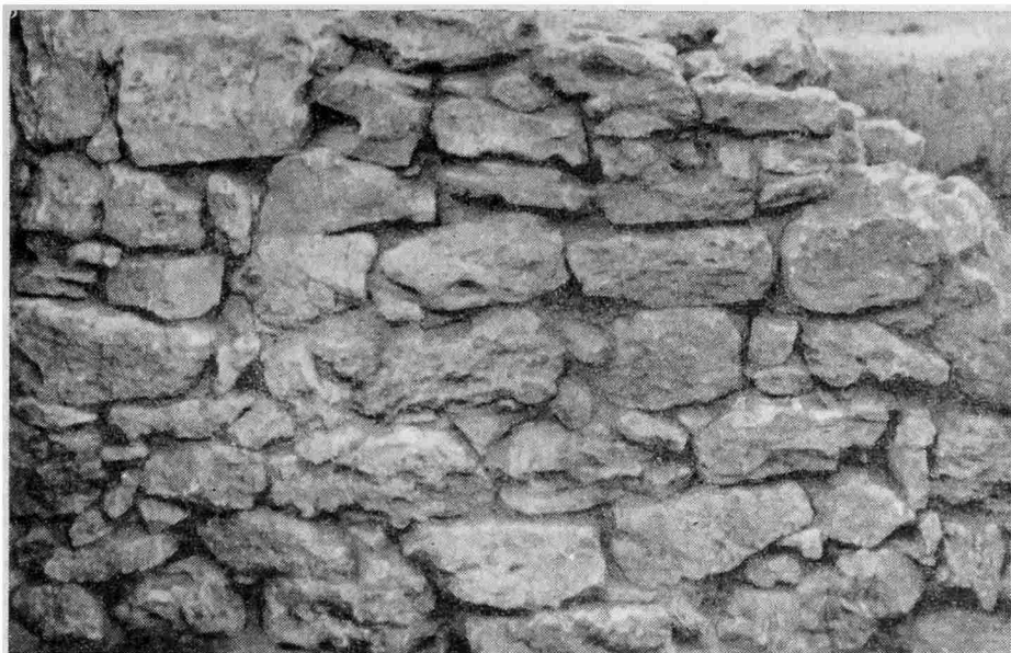
Рис. 7. Строительный комплекс № 6. Северный фас южной стены. Деталь
