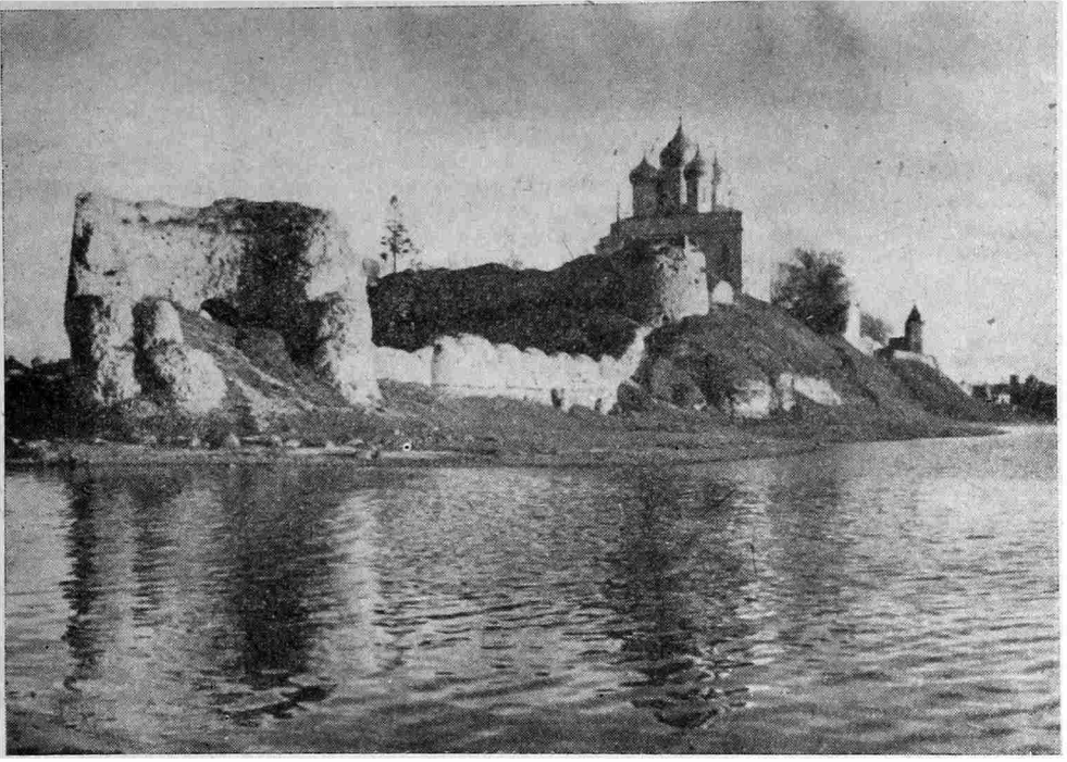
Рис. 1. Руины Кремля до реставрации, 1948 г. Вид с северо-западной стороны
