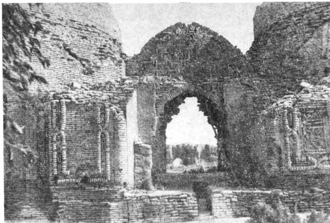
Рис. 2. Центральная часть южного фасада мавзолеев Ходжа Машад с полуразрушенным порталом в середине
