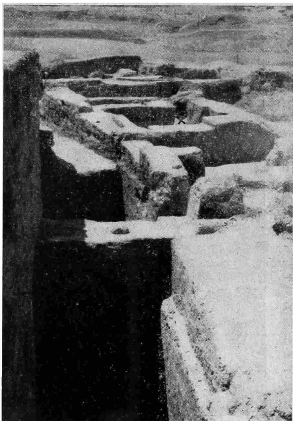
Рис. 7. Руины здания времени кушан (I—III вв.). Вид с северо-востока. Знаком X отмечено помещение с очагом
