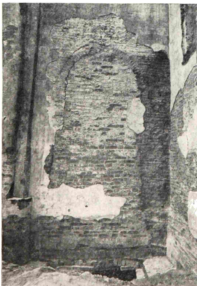
Рис. 3. Следы первоначального прохода в восточной стене южного притвора
