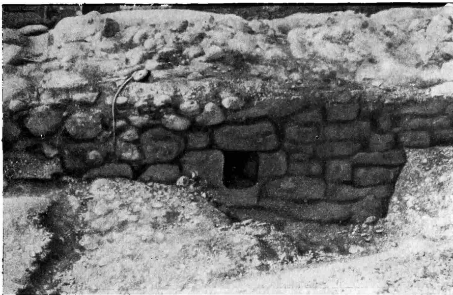
Рис. 2. Отверстие для стока воды в стене восточного укрепления
