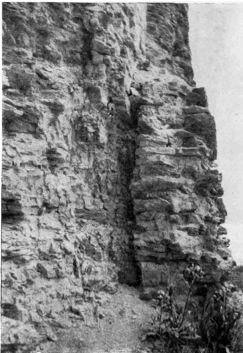
Рис. 4. Копорье. Уступ юго-западной стены близ северо-западной башни
