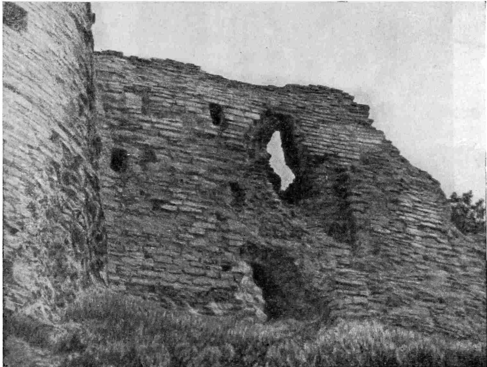
Рис. 3. Копорье. Фрагмент юго-западной стены крепости с местом расположения шва «Г»
