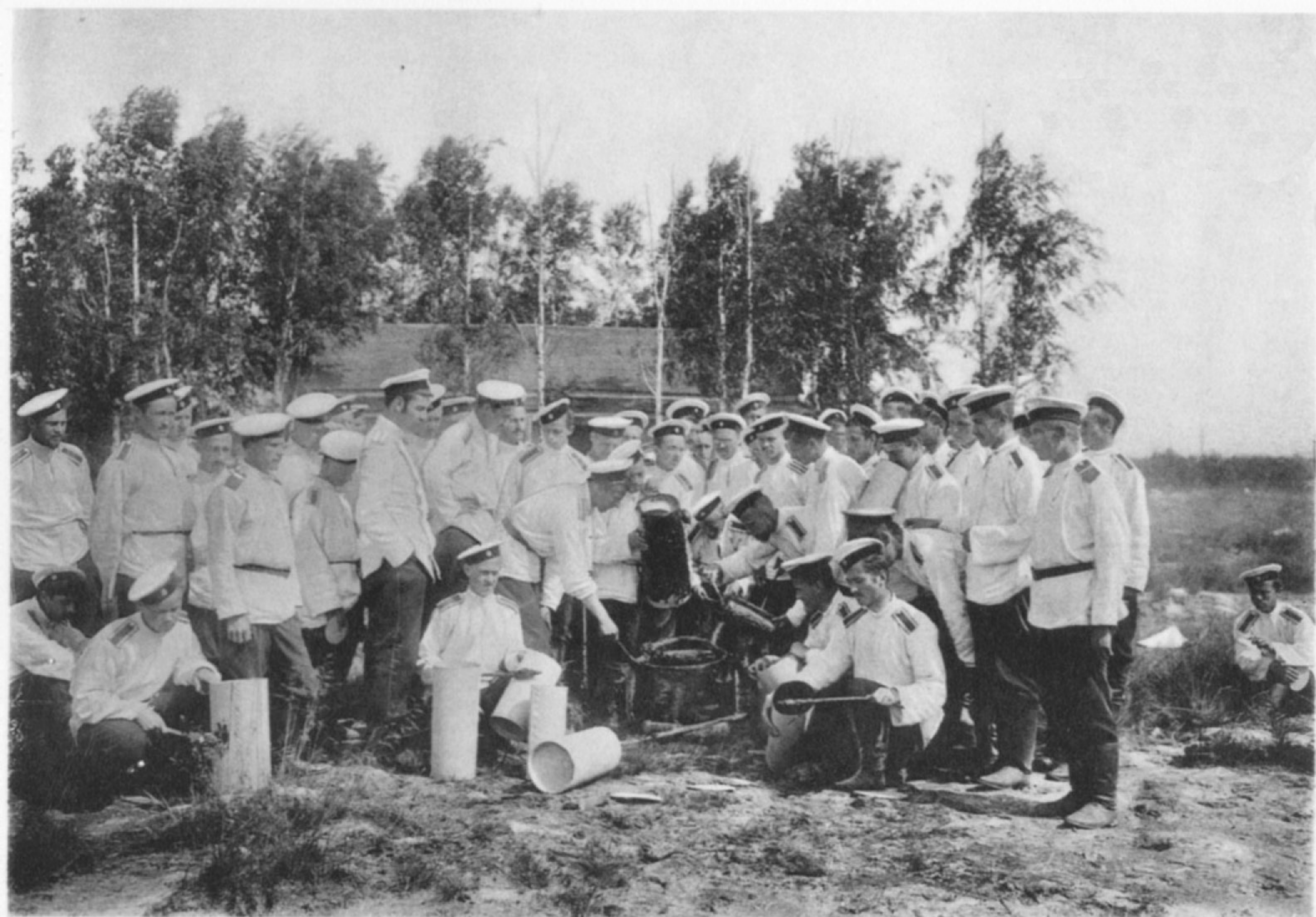
Подрывные работы (осмолка зарядных гильз).
