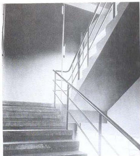
11. М.Краевский. Система софитовых светильников в интерьере лестничной клетки Баухауза в Дессау. 1926 г. Никелированная латунь, алюминий, опаловое стекло. Баухауз-архив, Берлин.
