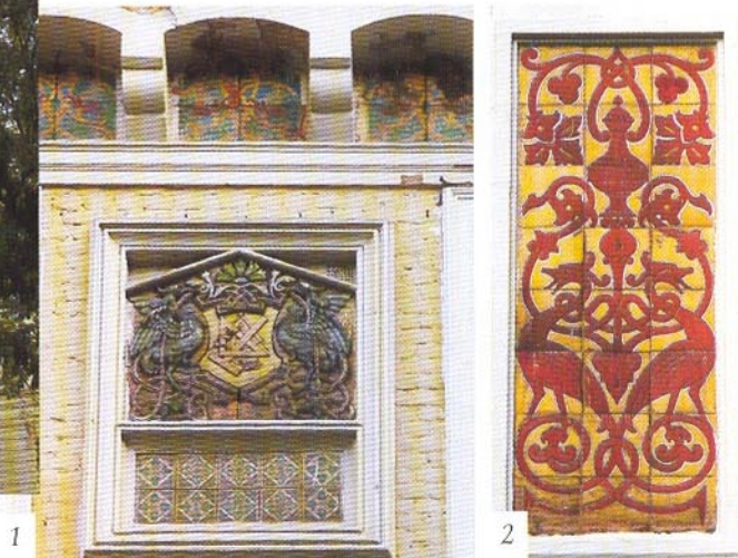
Эмблема Строгановского училища (музеема?) и изразцовый фриз (1); изразцовое панно по рисунку М.В.Васильева (?) (2) на фасаде доходного дома Строгановского училища (ул. Мясницкая, 24). Изготовлены в гончарной мастерской Строгановского училища в 1870-е гг.
