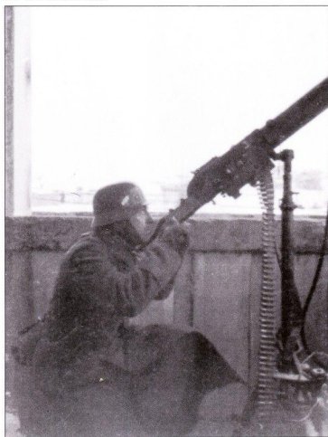
8 мм MG 07/12(o) — австро-венгерский станковый пулемет Schwarzlose . Пулемет приспособлен для стрельбы по воздушным целям.
