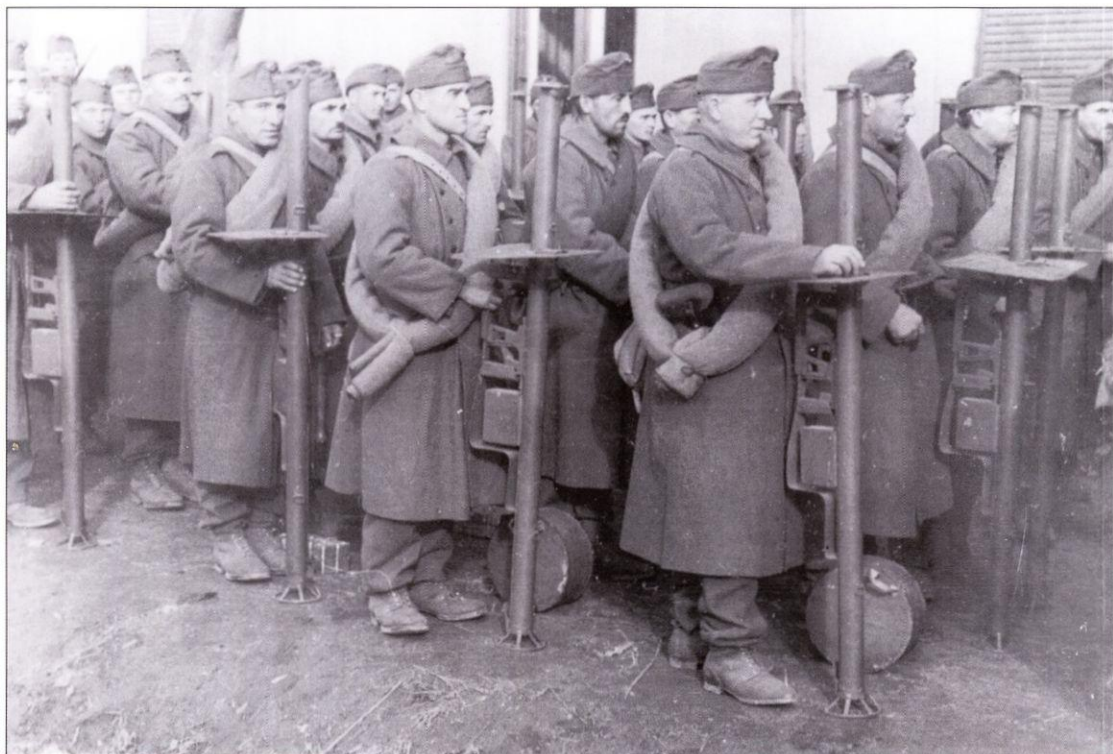
Оригинальная подпись к снимку, сделанному фотографом Фричем, утверждает, что это венгерские солдаты, вооруженные панциршеками. Если это и панциршеки, то какие-то необычные. Интерес представляет коробка, закрепленная на трубе позади пистолетной рукоятки. Также видно, что трубы имеют меньший калибр. Точно идентифицировать модель оружия не представляется возможным. Венгрия, ноябрь 1944 г.
