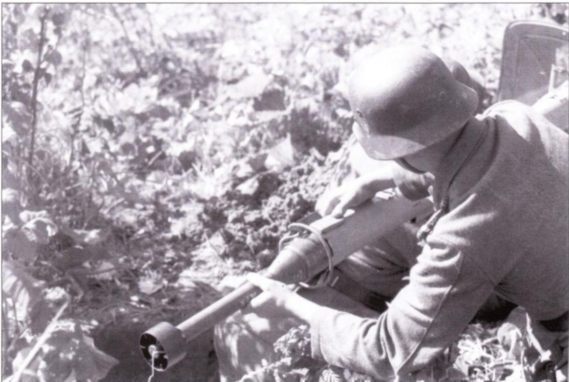
Зарядка ракеты. Заряжающий удерживает нажатым пружинный фиксатор и вставляет в трубу ракету. В задней части ракеты виден электрический провод, через который осуществляется пуск. Хотя снимок сделан в августе-сентябре 1944 г, ракета несет маркировку Arkt, что указывает на то, что она предназначена для применения зимой. Россия, август-сентябрь 1944 г.
