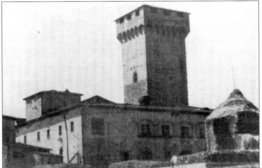
Итальянские сельские укрепления вроде этой отдельной башни под Понтассиеве в Тоскане. Сельские укрепления строились по тем же принципам, что и городские.
