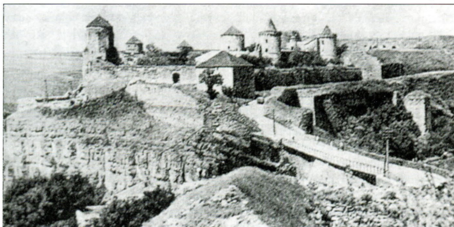
Крепость Каменец-Подольского, построенная в XI веке и постоянно укрепляемая вплоть до XVI века.
