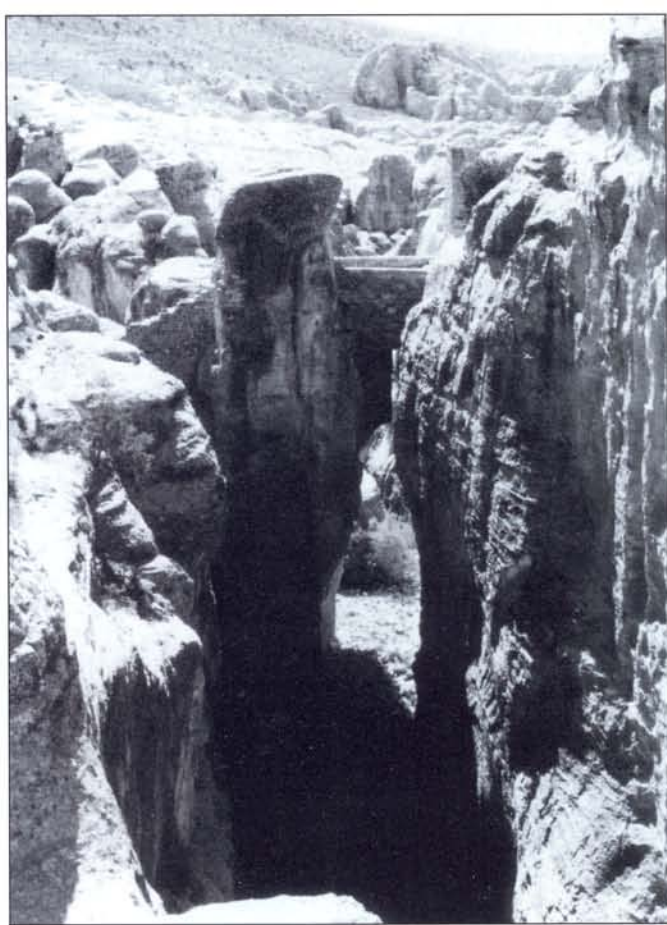
Под Эль-Буайрой строители расширили и выровняли существующий горный отрог. В центре виден туннель, пробитый в краю скалы. Каменные ступени и мост в настоящее время соединяют выход скальной породы с крепостью. Левая часть прохода отреставрирована. В XII веке здесь имелся перекидной мостик.
