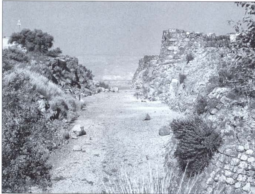
Крепость ордена госпитальеров Бельвуар сидит на крутом склоне долины, спускающемся к Иордану. С этой стороны замок защищен естественным склоном. С трех других сторон строители прорубили в скале ров. На снимке показан сравнительно мелкий ров северной стены.
