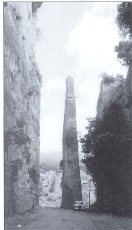
Скальная колонна, оставленная крестоносцами при создании рва в крепости Саон. Разумеется, скалу рубили не сами крестоносцы, а рабы или пленные. Ров отделяет крепость (слева) от остальной части холма (справа), тогда как колонна служила опорой для перекидного моста.
