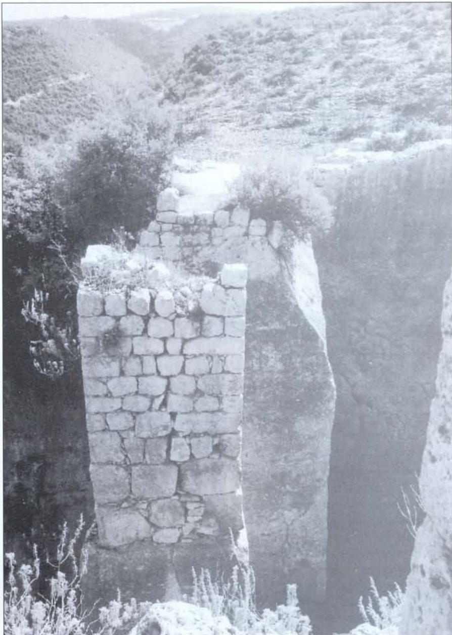
Верхняя часть каменной колонны выложена каменной кладкой. На эту колонну опускался перекидной мостик, соединявший внешнее плато с выступом скалы со стороны крепости.
