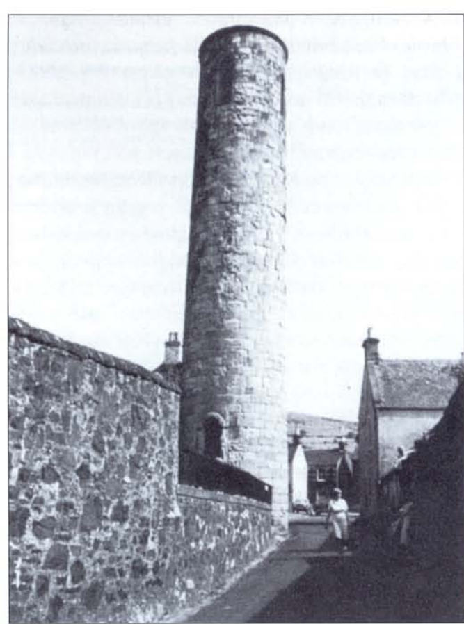
Башня Абермети в Файфе. Редко встречающееся шотландское убежище, наиболее типичное для Ирландии. Такие сооружения с расположенным высоко над землей входом предназначались прежде всего для защиты от сканинавских набегов.
