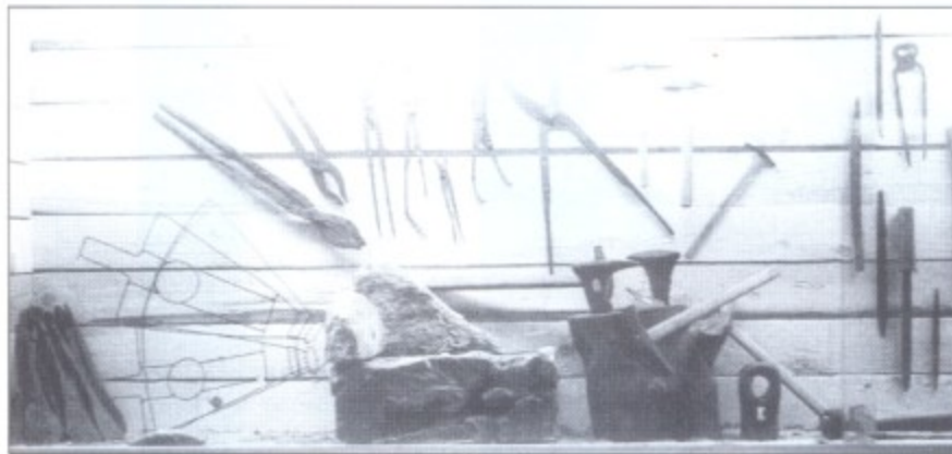
Частично реконструированная кузница эпохи викингов. В левом углу лежат слитки железа. На стене над наковальней, стоящей справа, находятся несколько кузнечных молотков. Кузнечный горн выложен из огнеупорного камня. Мехи в данном случае просто нарисованы на стене.
