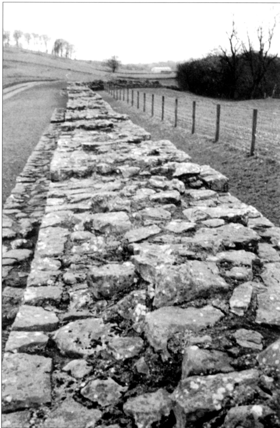
Стена к востоку от башни 48а (Виллоуфорд-Ист). Виден широкий фундамент, на котором построили узкую стену.
