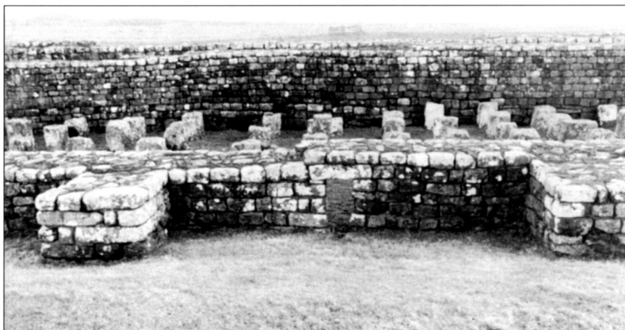
Контрфорсы северного амбара Хаустедса (Верковициум). Контрфорсы, также как поднятый пол и широкая крыша с большими свесами были характерными чертами конструкции римских амбаров. По середине видно вентиляционное отверстие.
