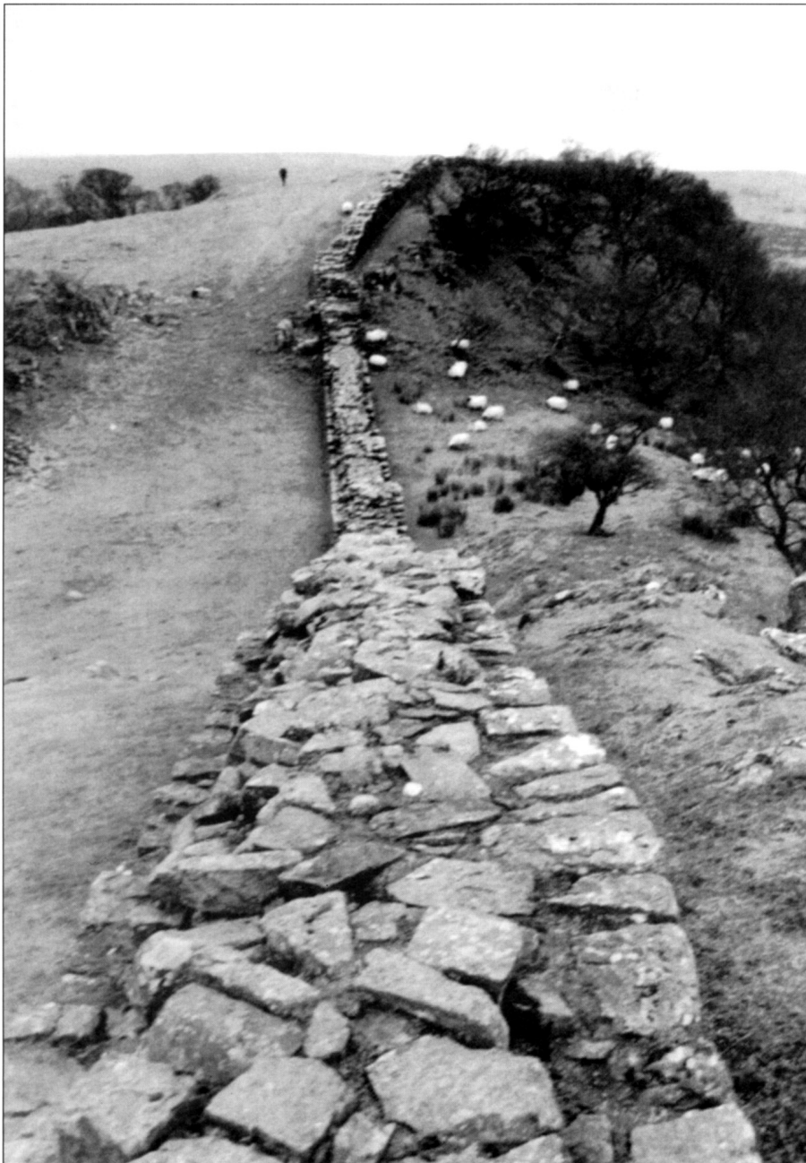
Стена у Уоллтаун-Крэгс, вид на юго-запад от башни 45а. Видны облицовочные камни и валуны сердцевины стены. Это так называемая «узкая стена».
