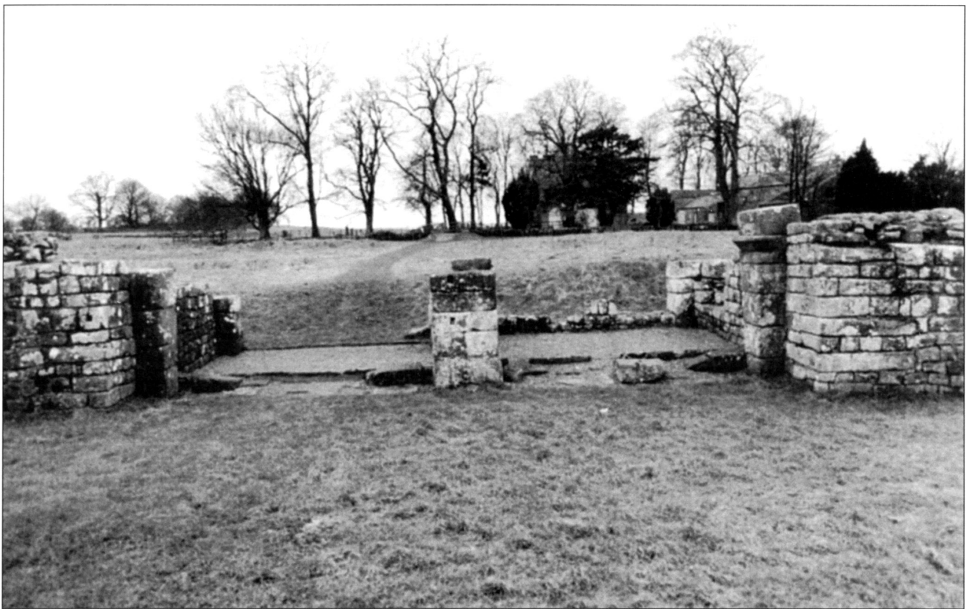
Восточные ворота форта Бердосвальд (Банна), вид снаружи форта. Интерес представляет двоянная арка и пятый камень северной арки (место, откуда начинается арка).
