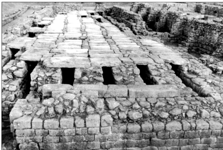
Поднятый пол амбара в Корбридже (Кория). В каналах под полом свободно циркулировал воздух, не давая образовываться сырости.
