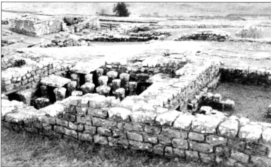
Часть северного крыла претория форта Хаустедс (Верковициум). Видна небольшая столовая с обогреваемым полом, сооруженная в IV веке. Командующий гарнизоном был довольно знатным человеком, требующим достойного уровня комфорта.
