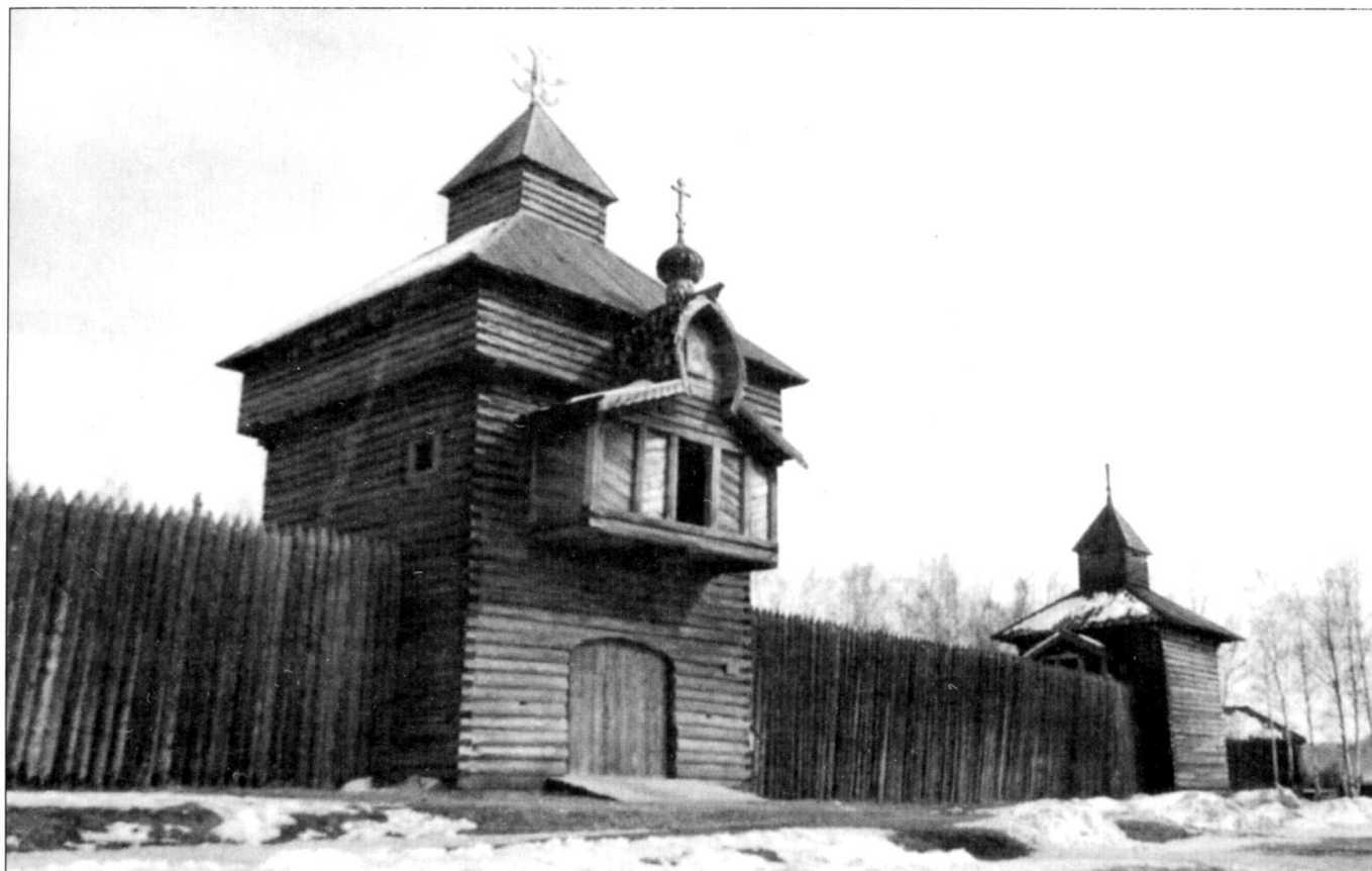
Воротная башня деревянной русской крепости XVII в., реконструированной в Талицком музее архитектуры и этнографии.
