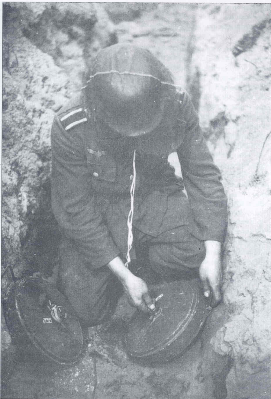
Санер готовит к установке противотанковые мины, вкручивает взрыватель T.Mi. Z.42 в мину Tellermine-42.
