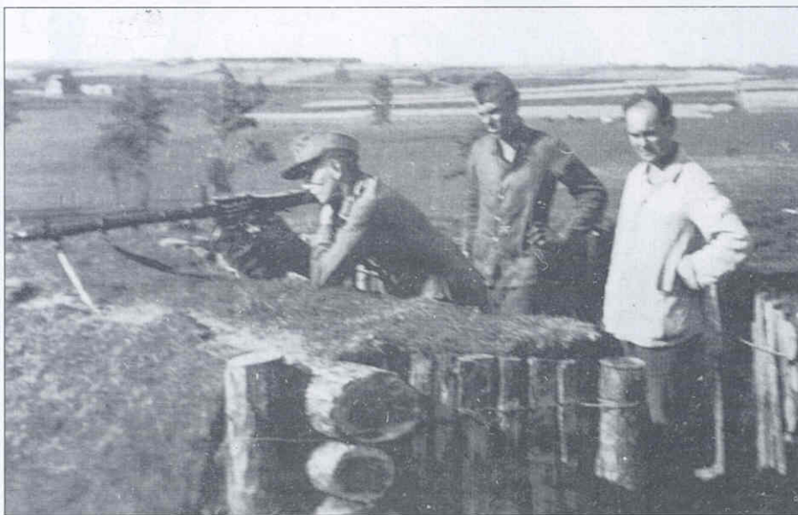
Пулеметная позиция. С приходом весны линии германской обороны покрылись сетью траншей, окопов и ходов сообщения. Стенки окопа и траншеи укреплены бревнами.
