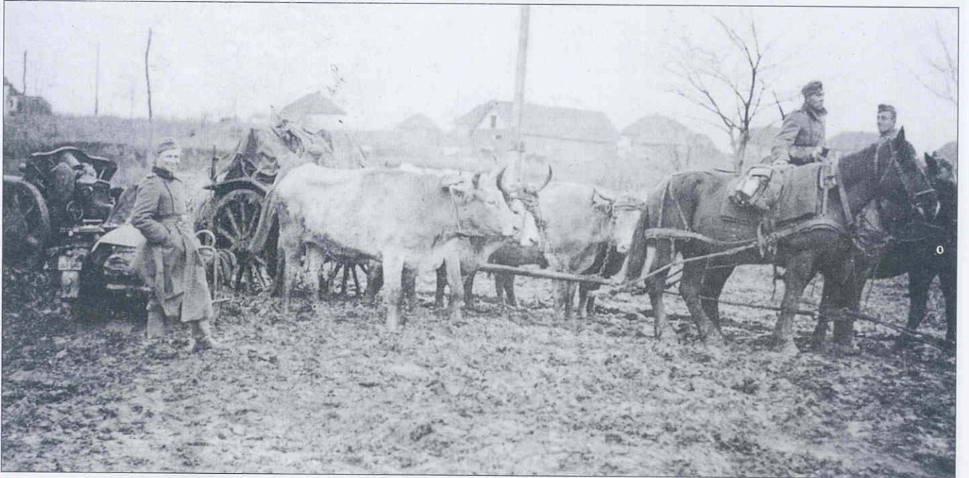
Интересное комбинированное транспортное средство: на помощь хилым германским лошадемкам пришли мощные украинские вола. Могучий тягач из четырех животных предназначен для буксировки гаубицы 10.5 cm leichte Feldhaubitze-18 и передка. Из-за узких колес германские орудия всегда было сложно буксировать по грязи и снегу. Положение частично улучшилось с внедрением колес с резиновыми шинами.
