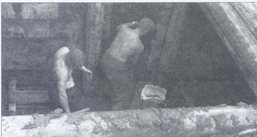
Постройка блиндажа. Сооружение из земли и бревен мало чем отличается от типичного блиндажа времен Первой мировой войны. Методы сооружения также остались прежними, основные орудия труда - лопатка и лопата.
