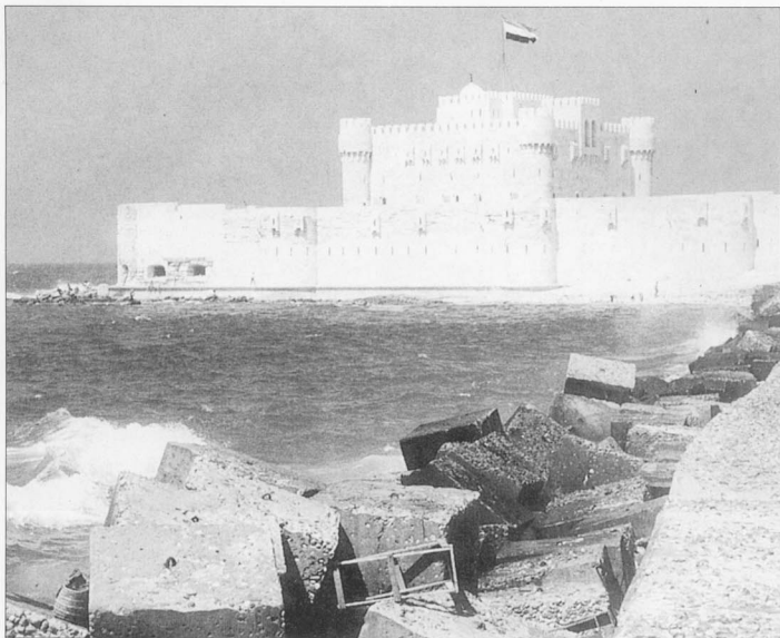
Замок, возведенный султаном Кайт-беем в александрийской гавани. Замок был вооружен пушками и имел внутреннюю цитадель, окруженную толстой, но низкой внешней стеной.
