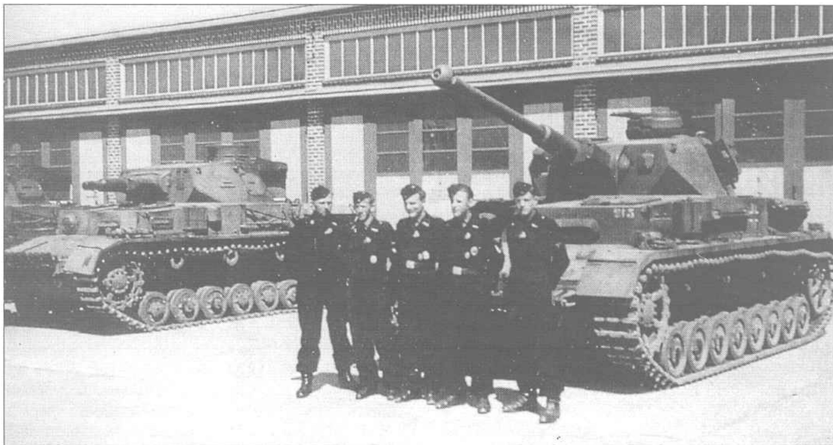
Вернувшиеся с фронта танки и танкисты 2-й танковой дивизии СС "Das Reich". Ближе стоит PzKpfw IV Ausf. F2 с длинноствольной 75-мм пушкой. Слева от него виден старый PzKpfw IV с короткоствольным орудием.
