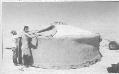
Сооружение гера. После того, как каркас собран, его обтягивают войлоком. Обшивка состоит из стен и кровли.
