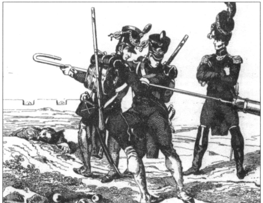
Два канонира линейной артиллерии прочищают ствол пушки малого калибра при помощи банника с изогнутой рукояткой, 1807-1812 гг. Банник с изогнутой рукояткой был введен Грибовалем специально для обслуживания легких пушек. Рядом стоит офицер пешей артиллерии Императорской гвардии.
