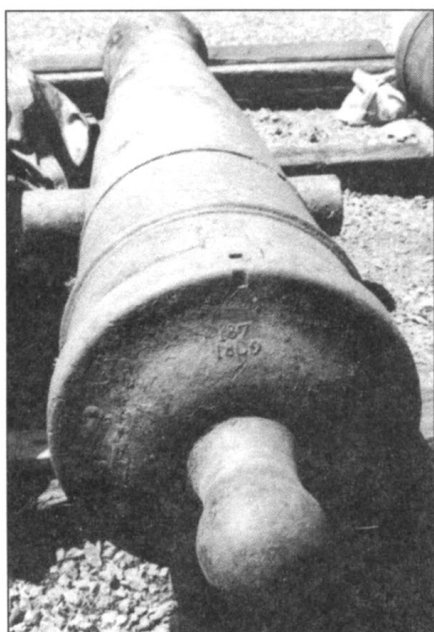
Вид сзади французской морской 36-фунтовой железной пушки модели 1786 г., отлитой в Льеже в 1809 г. На ней нанесены маркировки «187» и «1809».
