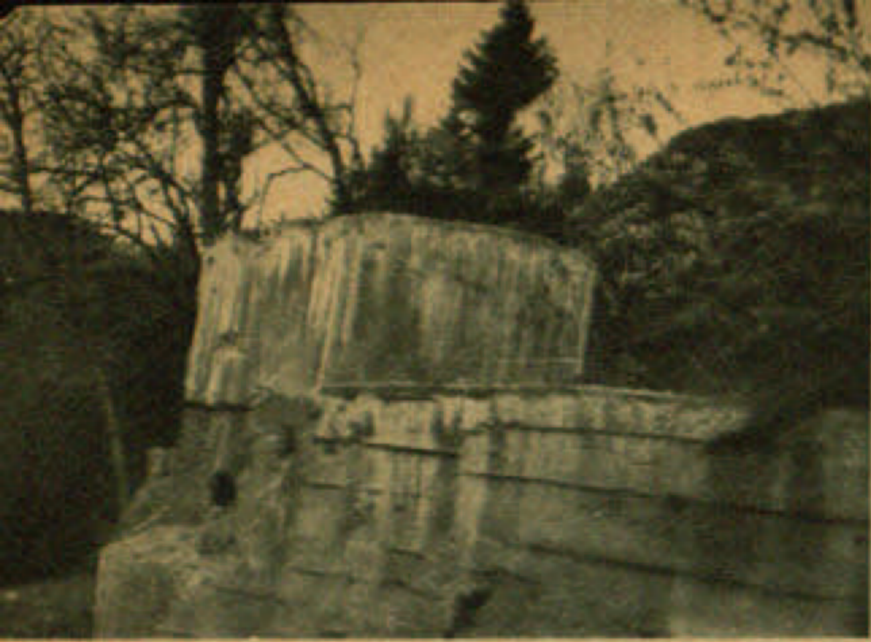
Zerschossener Bunker in Prävali
