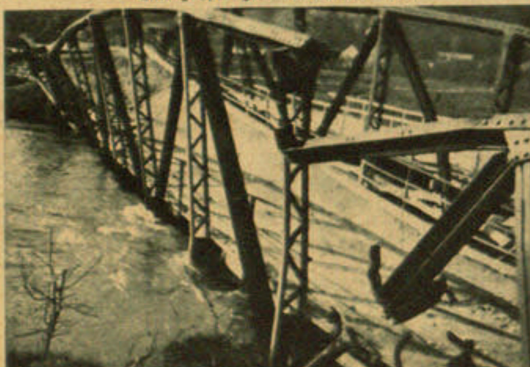
Eine gesprengte Brücke im Mießtal
