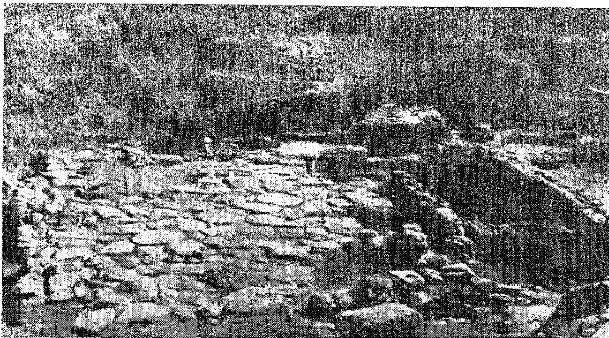
Рис. 9. Вымостка двора и прилегающие помещения восточного здания.
